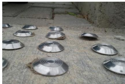
Elementos de relevo com má aplicação – alto risco de quedas
